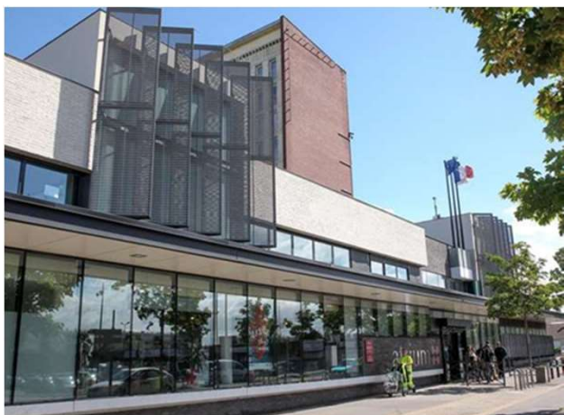
L'ATRIUM, pôle de services publics
